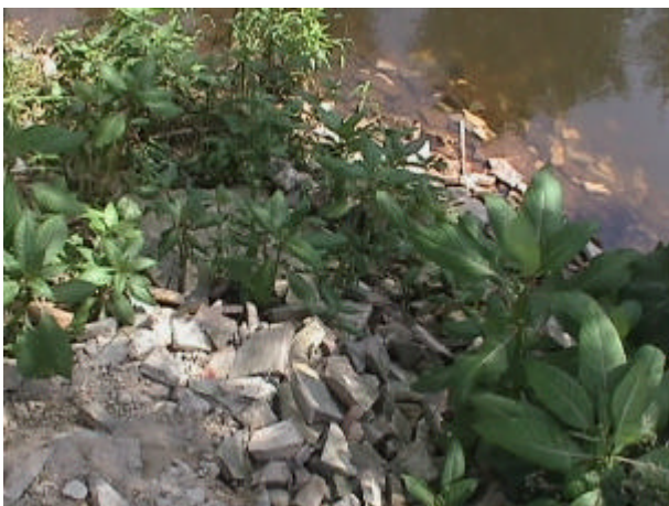
les gravats continuent de s'accumuler le long de la Bruche
