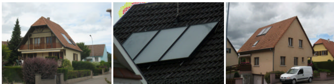
Trois toits équipés de solaire thermique, le premier à Achenheim les deux autres à Oberschaeffolsheim
