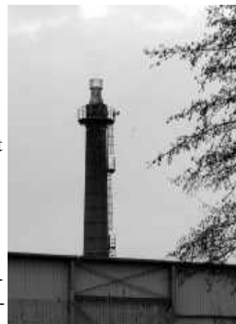
La sortie de cheminée endommagée par la tempête du 26 décembre 1999 a été remise en état.
