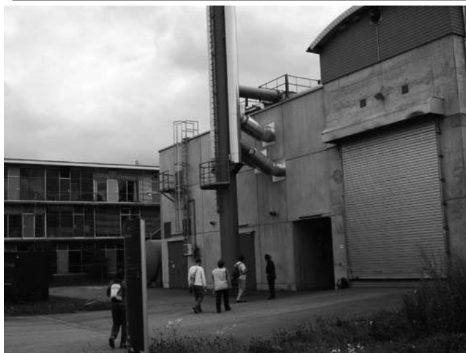
Centrale à co-génération au quartier Vauban à Freiburg
