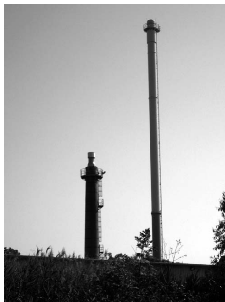
Malgré une nouvelle cheminée beaucoup plus haute destinée à mieux disperser les odeurs résiduelles, les odeurs sont loin d'avoir disparu...
