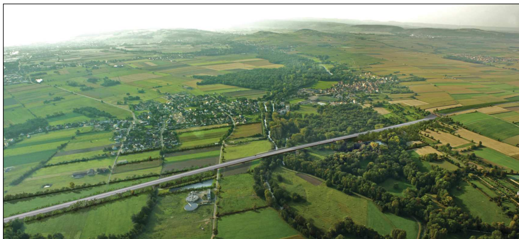
Vue aérienne du Grand Contournement Ouest de Strasbourg traversant la Bruche
